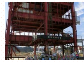
南三陸町防災庁舎跡
